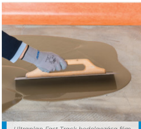
Ultraplan Fast Track bedolgozása fém simítóval
