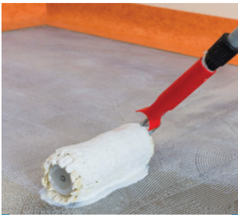
Eco Prim T bedolgozása hengerrel
