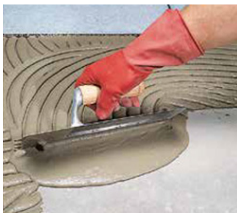
Terítés félköríves fogú simítóval
