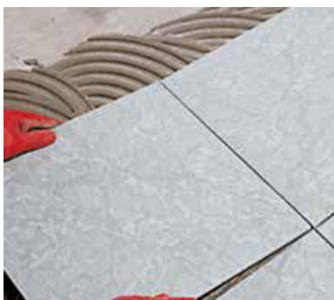
Porcelán burkolólapok fektetése
