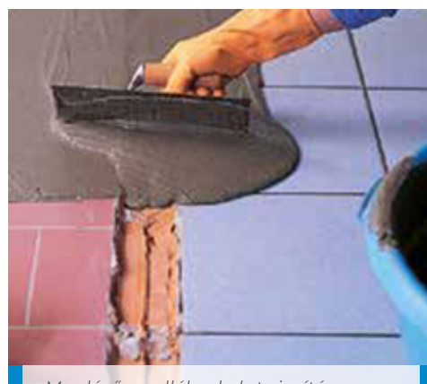
Meglévő padlóburkolat simítása Adesilex P4-gyel
