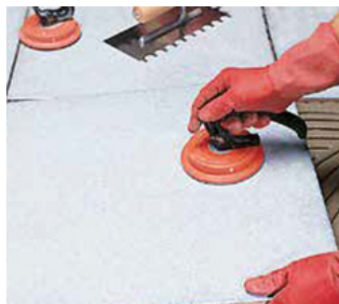
Nagyméretű burkolólapok fektetése
