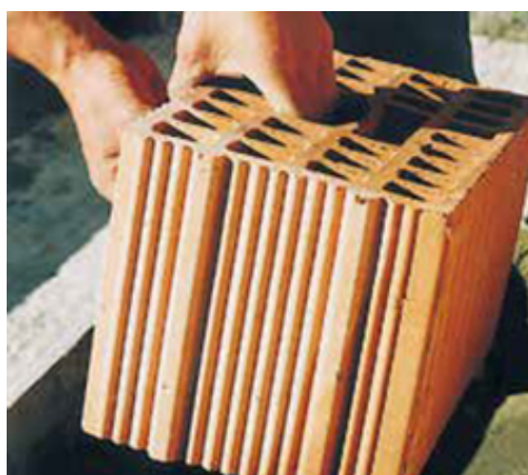
Falazóblokk mártása Adesilex P4-be
