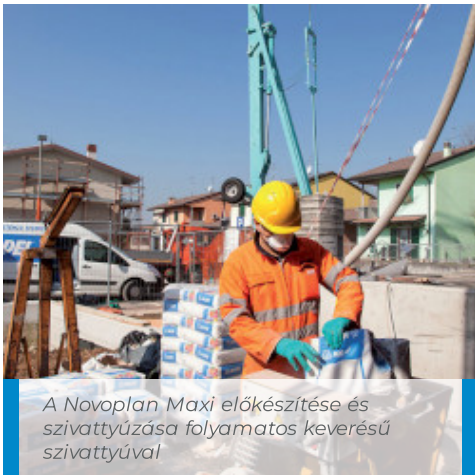
A Novoplan Maxi szivattyúzása és kiegyenlítése
