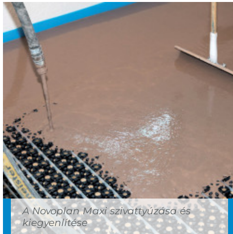
A keverék terítése a kompakt fűtési rendszer teljes beágyazása érdekében
