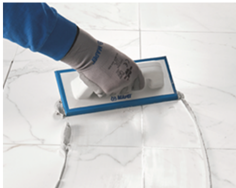
Ultracolor Plus terítése padlón gumisimítóval
