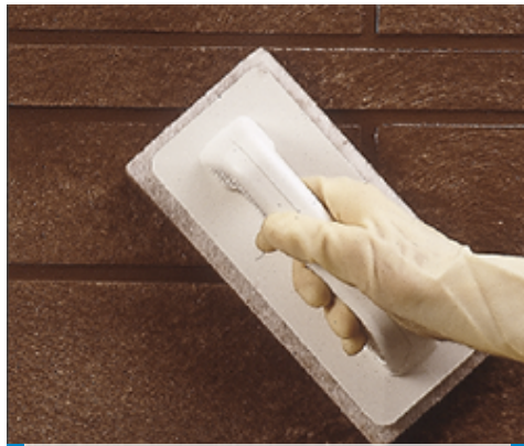
Fugák tisztítása Scotch-Brite®-tal (ha a termék már részben megkötött)
