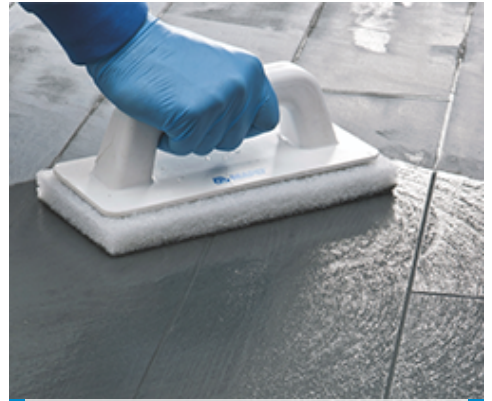
Fugák tisztítása Scotch-Brite®-tal (ha a termék már részben megkötött)
