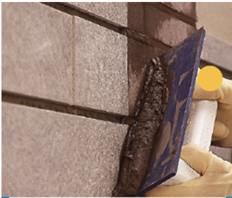
Ultracolor Plus felhordása falra gumilehúzóval
