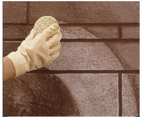
Fugák tisztítása és végtisztítása szivaccsal
