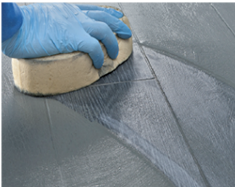
Fugázóhabarcs lemosása és végtisztítása kemény cellulóz szivaccsal
