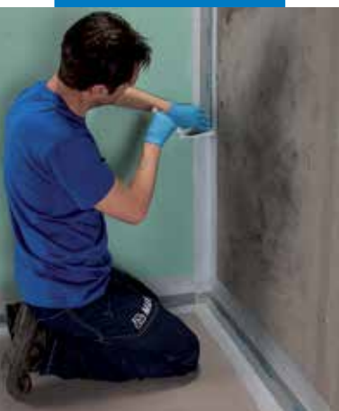
Mapeband PE 120 mandzetta elhelyezése kifolyó körül Mapegum WPS-sel
