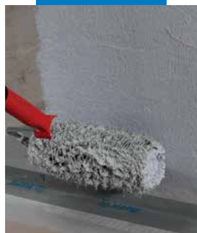
Mapegum WPS felhordása hengerrel
