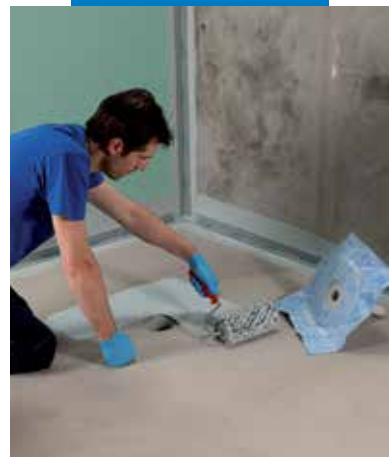
Drain Vertical csatlakoztatása Mapegum WPS -sel
