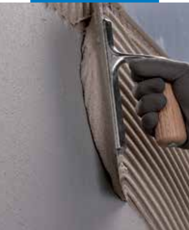
Padlóburkolat elhelyezése Ultramastic III használatával
