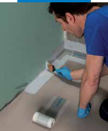
Mapeband PE 120 szalag elhelyezése Mapegum WPS-sel
