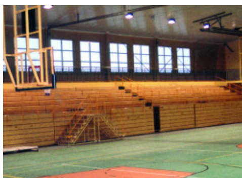
Tornateremben, PVC és linóleum burkolat előtt felhordott Primer G alapozóra példa – Gdansk Orunia Tornaterem – Lengyelország
