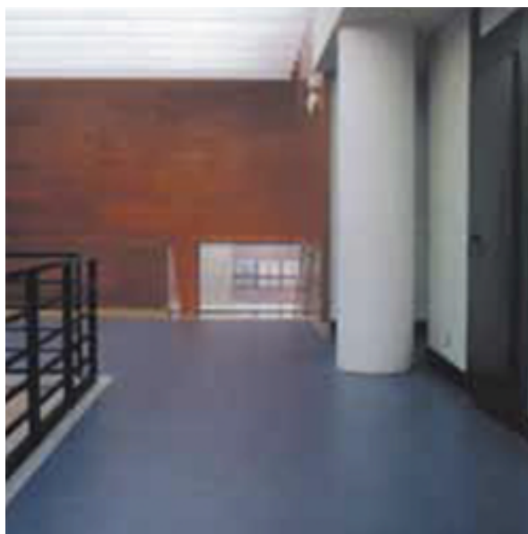
Példa Ultraplan-nal kiegyenlített aljzatfelületre ragasztott linóleumra, Morzòn Conservatory - Spanyolország
