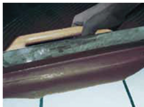
Ultraplan bedolgozása fémsimítóval meglévő kerámiaburkolatra Mapeprim SP előzetes feldolgozása után
