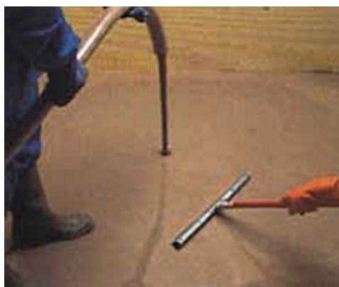
Ultraplan bedolgozása szivattyúval és lehúzóval
