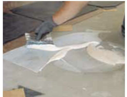
Példa berakásos PVC fektetésére Ultraplan-nal kiegyenlített aljzatra - CD2 - Milánó- Olaszország
