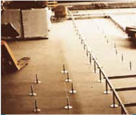
Ultraplan-nal kiegyenlített födém álpadló fektetése előtt
