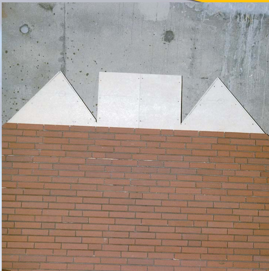
Burkolótégla ragasztása PROMAT-lemezre ADESILEX P9-cel (Müllheim városközpont metróállomás)
