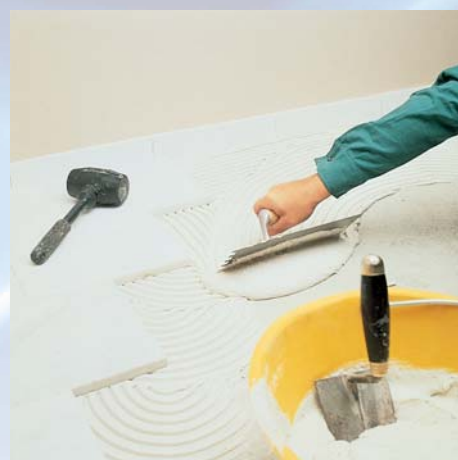
Carrarai márvány lerakása GRANIRAPID fehérrel
