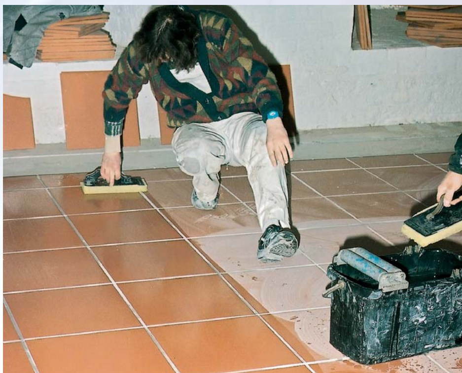
Cotto-burkolat fugázása ULTRACOLOR PLUS-szal
