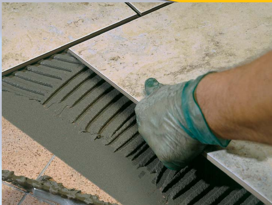
Új csempe lerakása KERAFLEX-szel régi kerámia burkolóanyagra
