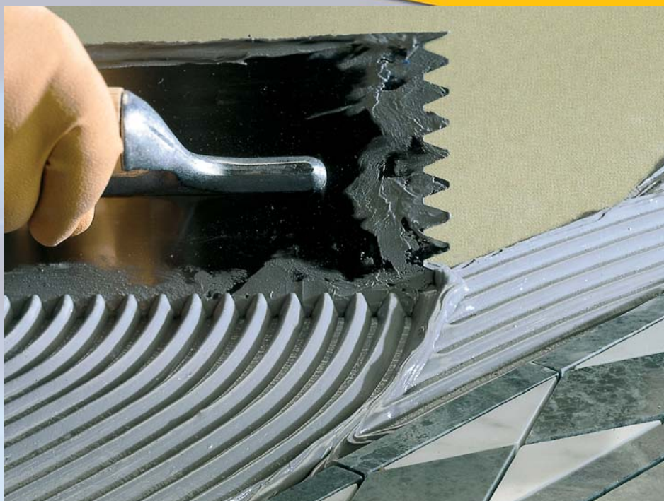
A KERALASTIC poliuretán gyanta alapú ragasztóanyag felhasználása nagy alakíthatóságot biztosít.
