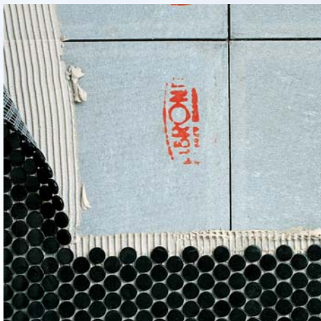
Mozaik lerakása cementkötésű farostlemezre ULTRAMASTIC III-mal
