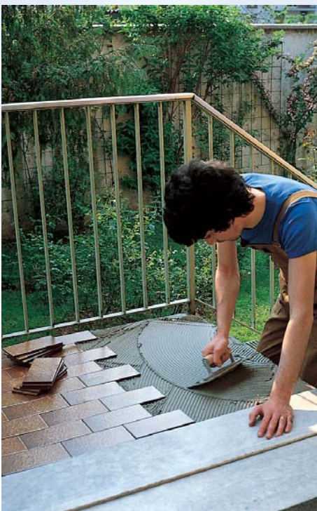
Kerámia csempék lerakása GRANIRAPID-dal MAPELASTIC szigetelő rendszerre
