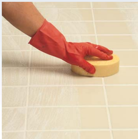
Burkolat tisztítása kemény szivaccsal
