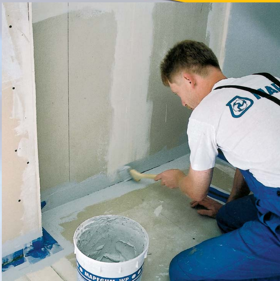
A MAPEGUM WPS szigetelés kétrétegű felhordása
