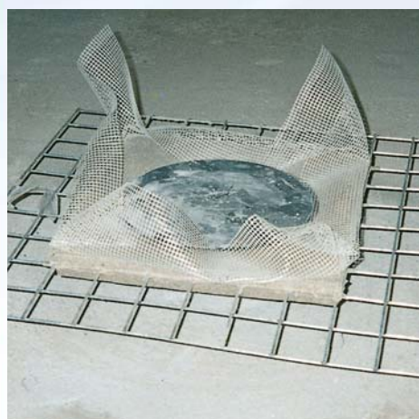
Egy példa az alternatív szigetelésekhez alkalmas lefolyóra
