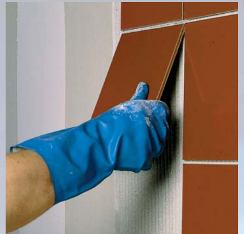
Csempe ragasztása KERAFLEX (fehér) vékony ágyazású ragasztó habarccsal
