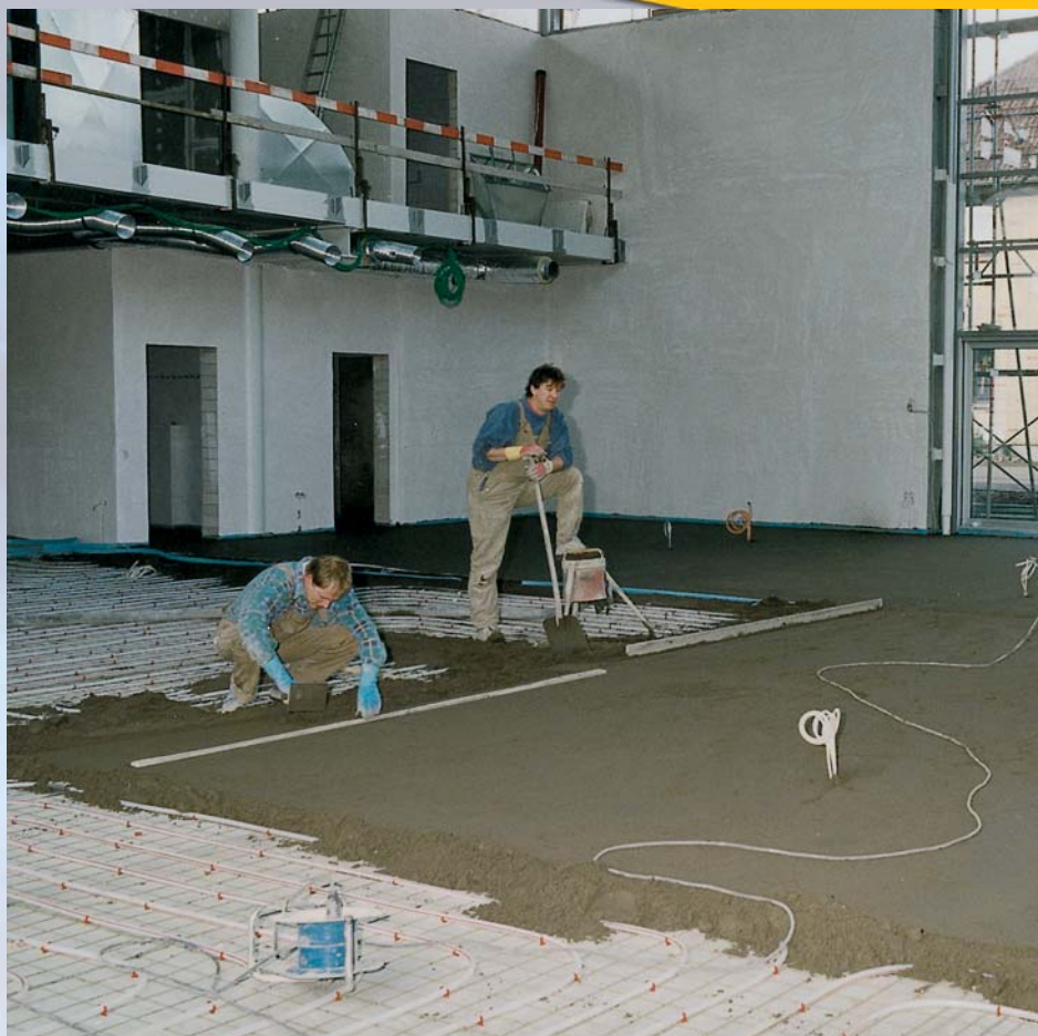
Egy gyorsan használatba vehető fűtött padlókonstrukció előállítását a gyorsan kötő esztrichcementtel a MAPECEM-mel
