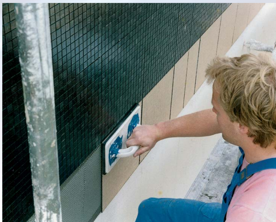
Az előoldalon ragasztott üvegmozaik felragasztása a homlokzatra KERABOND-dal és ISOLASTIC-kal
