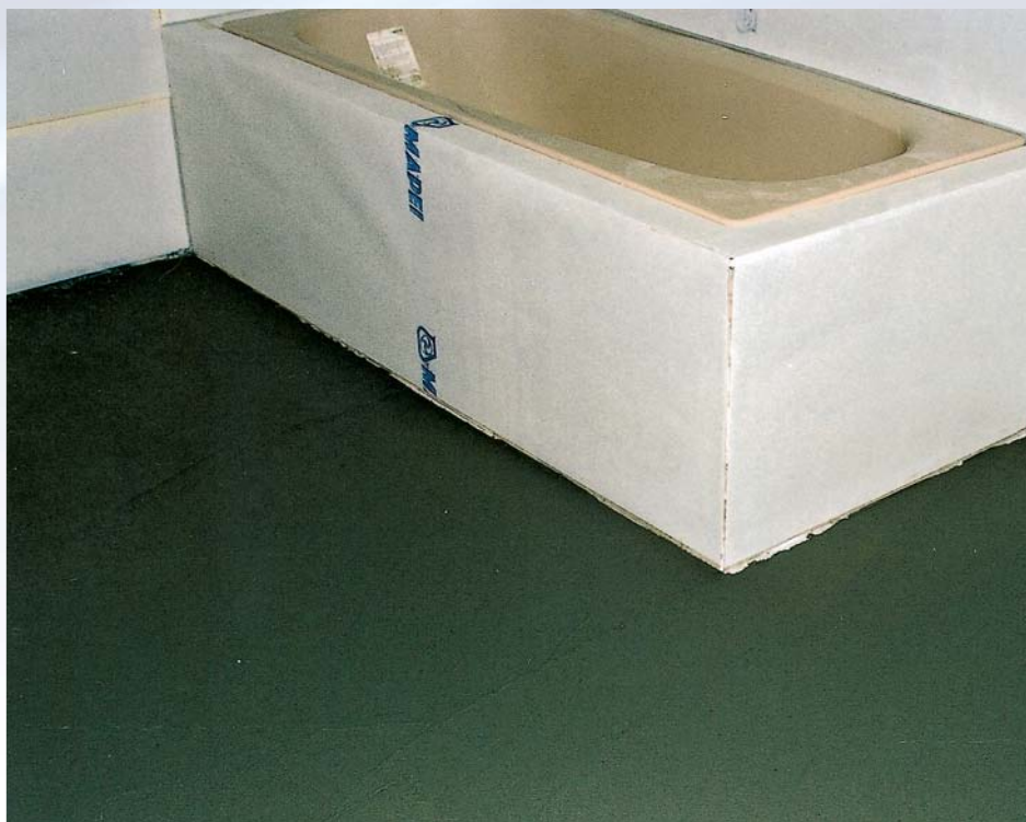
Fürdőszoba padlószigetelése MAPELASTIC-kal
