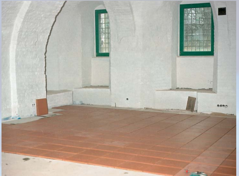
Cotto-burkolat lerakása a gyorsan megkötő folyékony ágyazású ragasztó habarccsal, az ADESILEX P4-gyel
