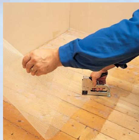
Üvegszálas elválasztó szövet felszögezése a száraz alapozásra
