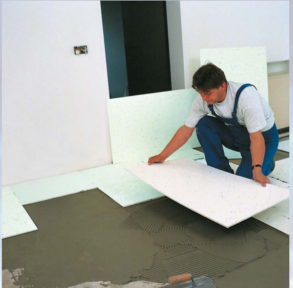
A MAPEFONIC-PAD lemezeket a ROLLCOLL diszperziós ragasztóval kell leragasztani.
