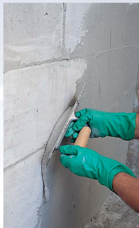
Porózus betonszerkezetek kiegyenlítése NIVOPLAN-nal
