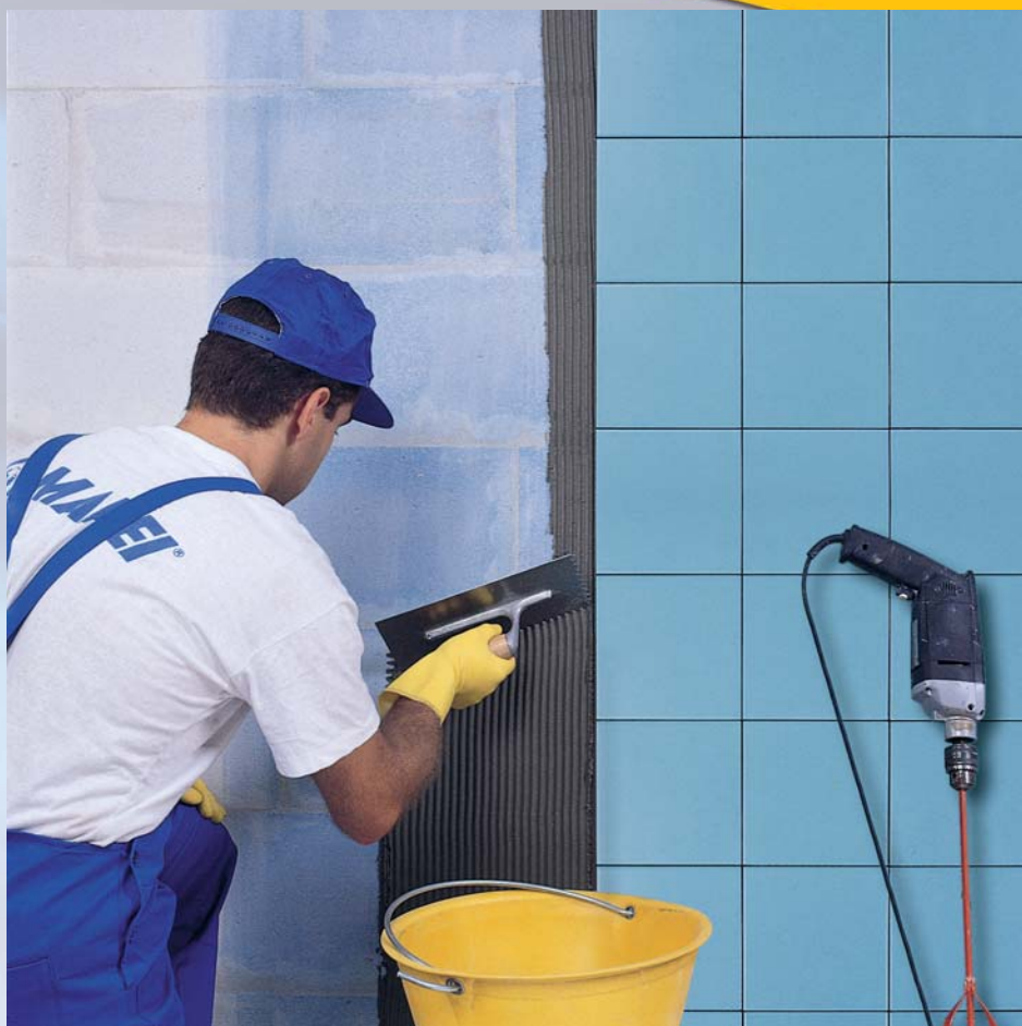
Kerámia csempék felrakása rugalmas, vékony ágyazású ragasztó habarccsal, a KERAFLEX-szel
