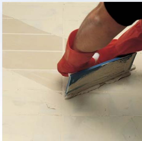
Burkolat fugázása KERAPOXY-val
