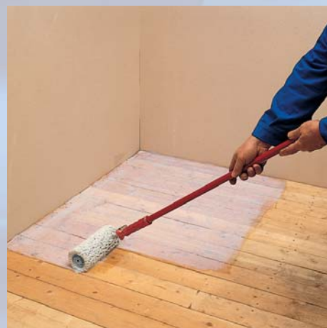
Deszkák alapozása MAPERIM SP-vel
