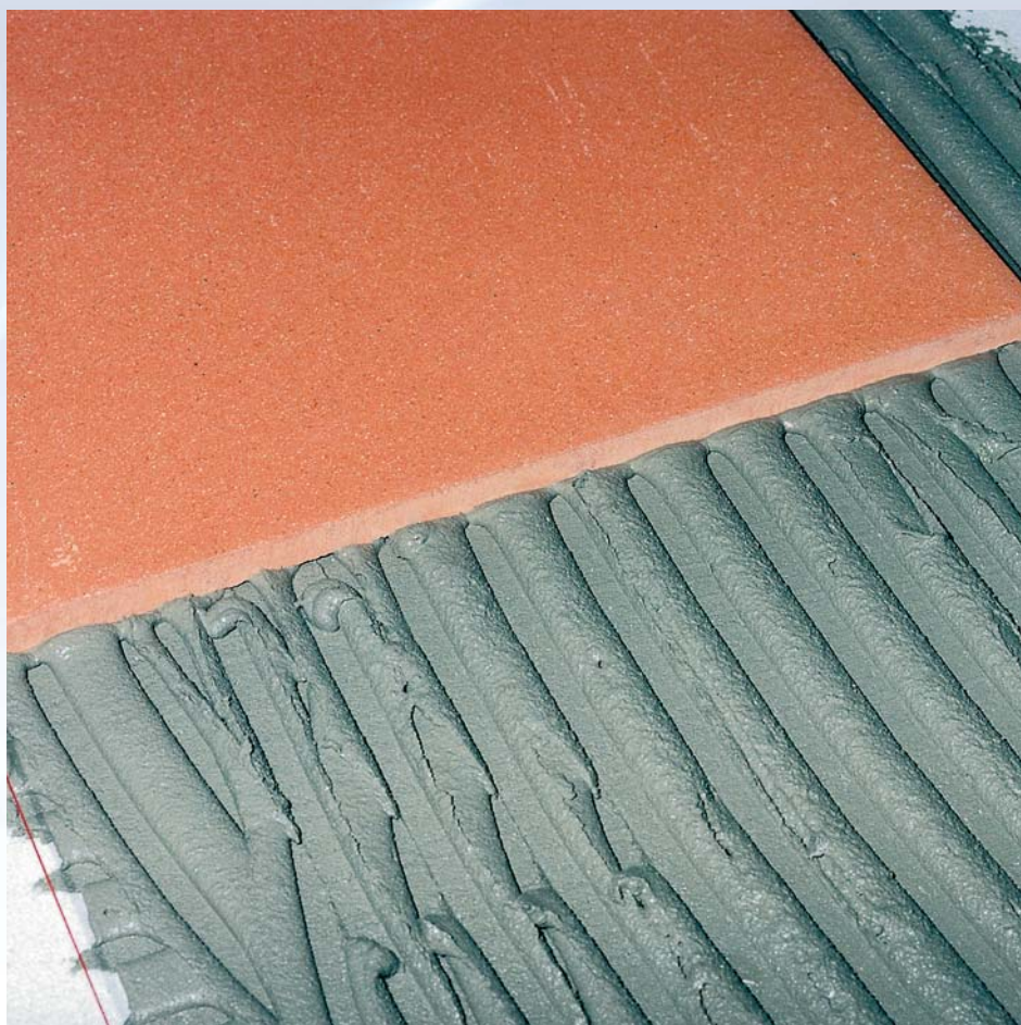
Terrakotta csempe lerakása KERAFLEX MAXI-val kalciumszulfát esztrichre
