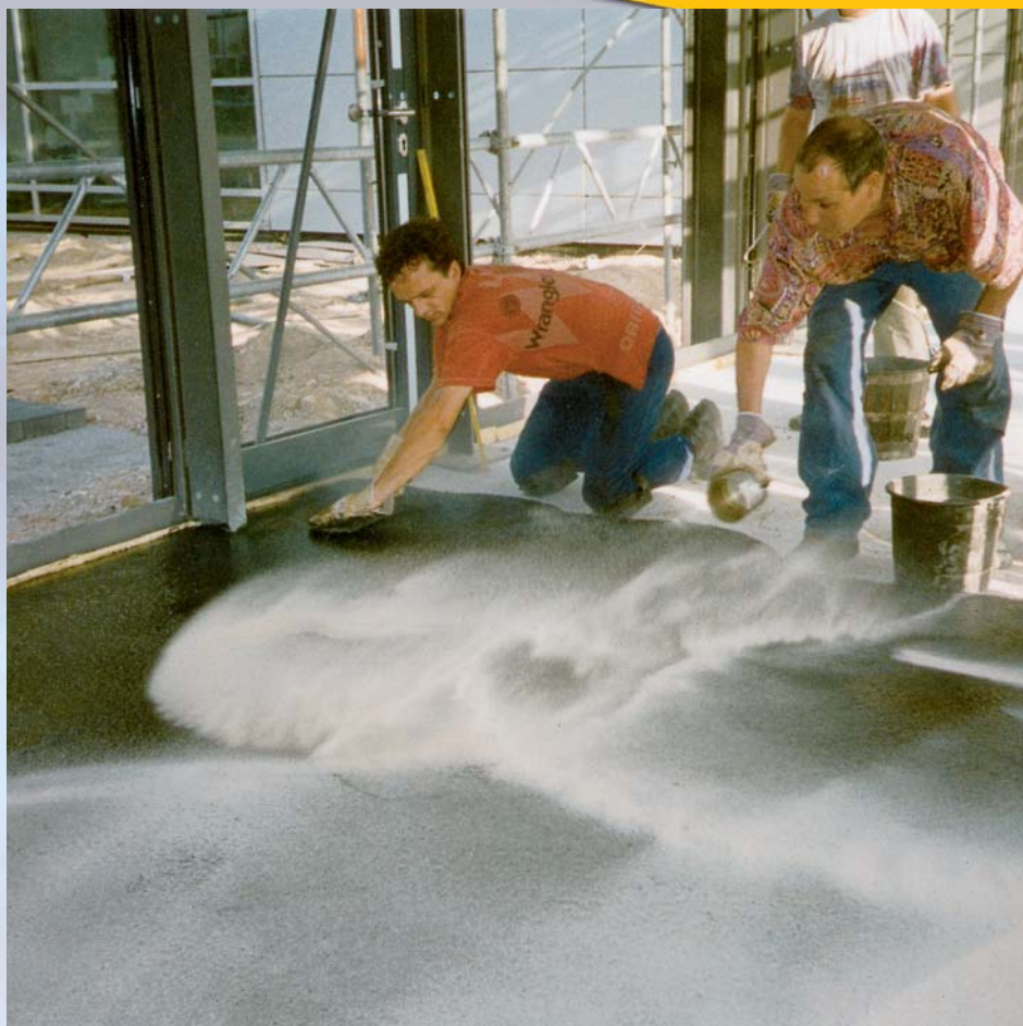
Öntött aszfalt szórása
