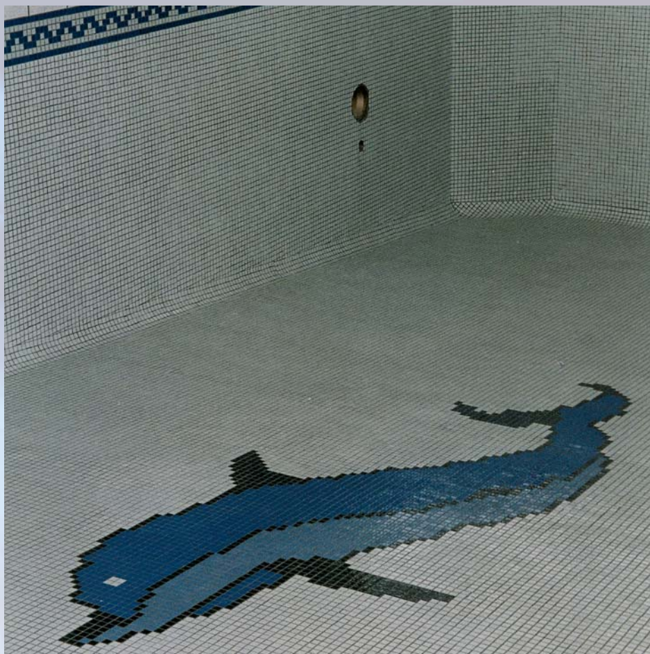
Mozaikkép lerakása úszómedencébe (ragasztás GRANIRAPID-dal.)
