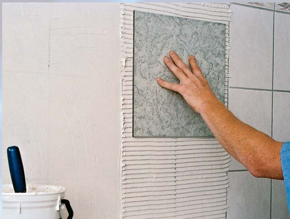
Csempék felrakása csempére ULTRAMASTIC III-mal
