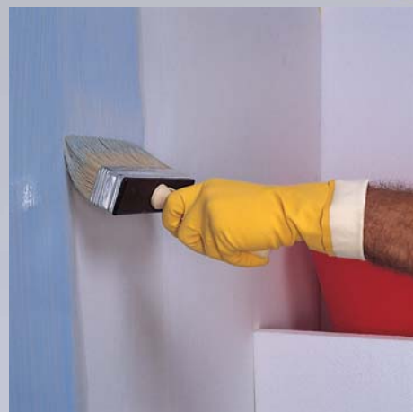
Gipszvakolat alapozása PRIMER G-vel
