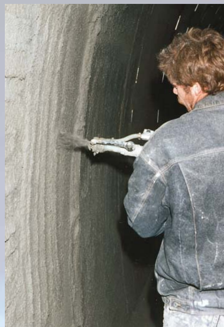
A betonfelület szóró technológiás kiegyenlítése NIVOPLAN-nal
