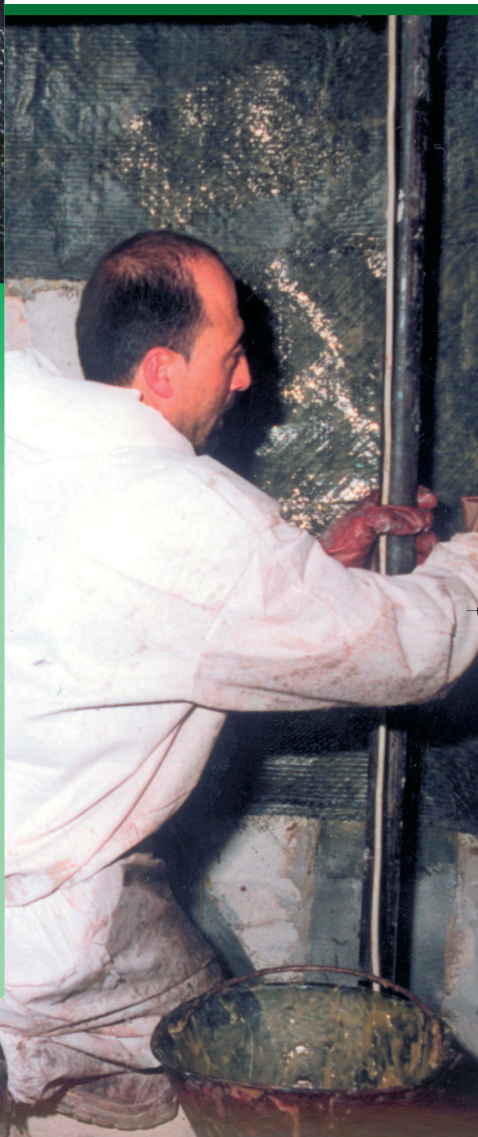
Szent Lucia Templom Keresztelőkápolnája: MAPEWRAP PRIMER 1, MAPEWRAP 11, MAPEWRAP 31, MAPEWRAP C UNI-AX, MAPEWRAP C QUADRI-AX, ADESILEX PG1, EPOJET, MAPE-ANTIQUÉ MC és ANTIPLUVIOL S
