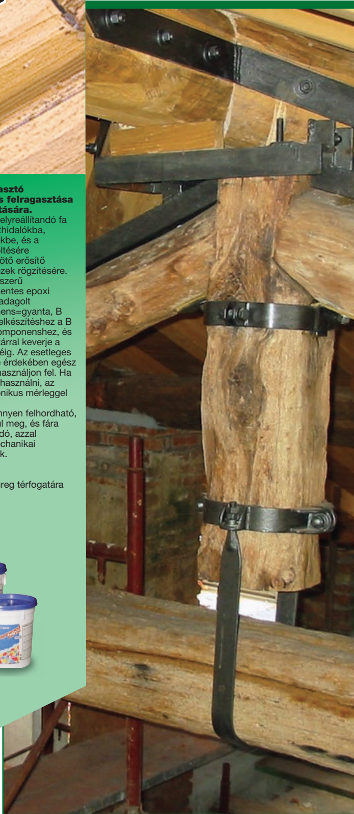
Contadino-i Múzeum - Milánó - Olaszország Faszerkezet helyreállítása: MAPEWOOD PRIMER 100, MAPEWOOD GEL 120, MAPEWOOD PASTE 140
