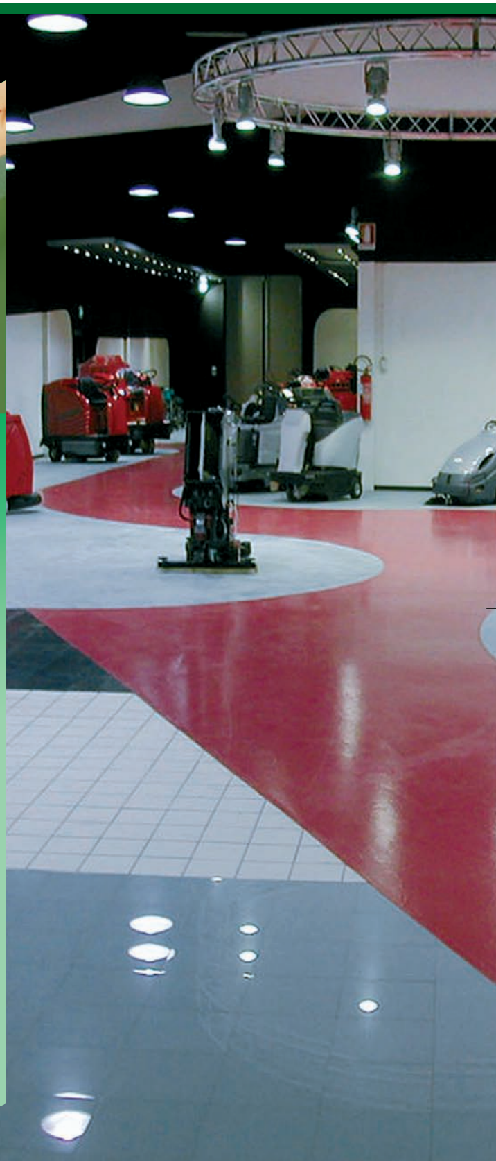
IP Cleaning Industria - Bagno - Olaszország. Új burkolat készítése: PRIMER G, ULTRATOP, MAPEFLOOR I 300 SL, MAPECOLOR PASTE
