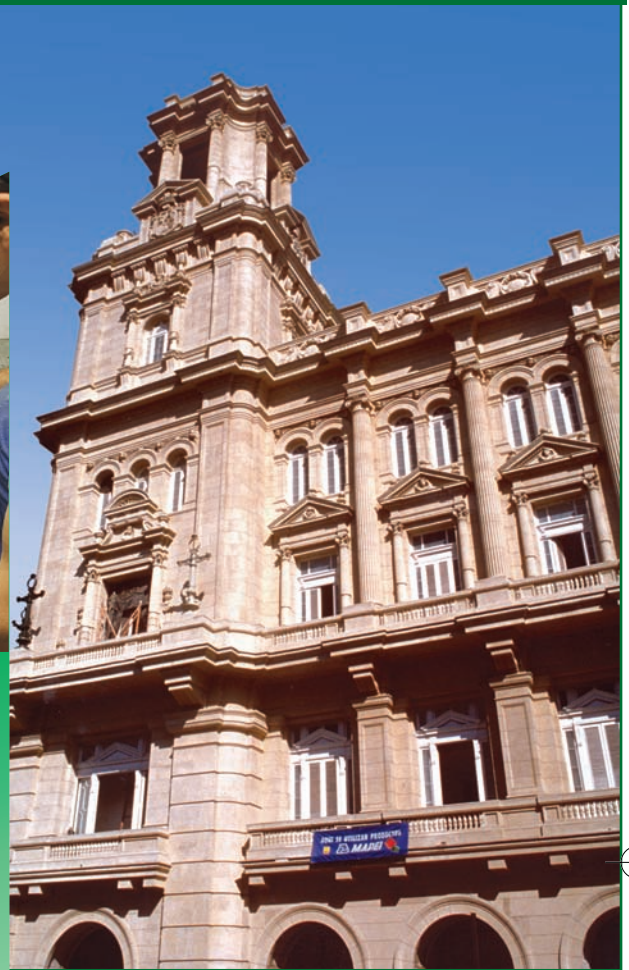
Osztrák Palota - Havanna - Kuba Az épület homlokzatának védelme és helyreállítása a köv. termékekkel: MAPEGROUT TISSOTROPICO, MAPEFER, MAPE-ANTIQUE FC, MAPE-ANTIQUE MC, MAPE-ANTIQUE LC, SILEXCOLOR PITTURA
