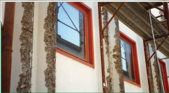
A&C Adivar Comifar Ipari csarnok - San Nicolo, Tordino - Olaszország Az ipari szerkezet védelme és helyreállítása a köv. termékekkel: MAPEFER, STABILCEM SCC, MONOFINISH, MALECH, ELASTOCOLOR RASANTE, SILANCOLOR PRIMER, SILANCOLOR PITTURA
